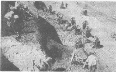
Початок будівництва "Запоріжсталі"
