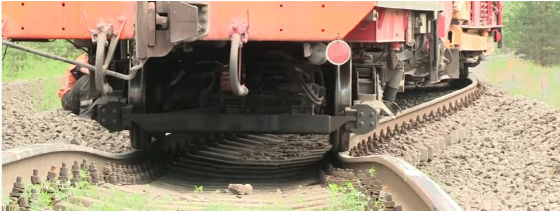
Викид безстикової ділянки колії/Railway track buckle
